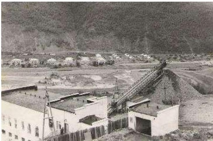
*ФЗЦО заработало. Приемный бункер и дробильно-сортировочное отделение фабрики.*
